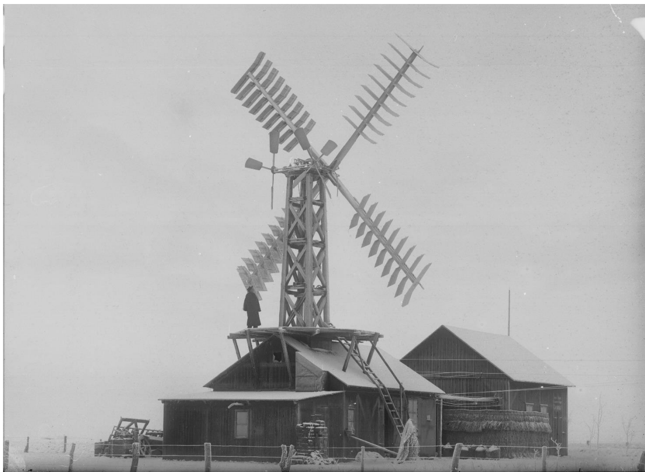
Figur 2: Den første el-producerende vindmølle, bygget 1891 af møllebyggerfirmaet N.J.Poulsen, Esbjerg. Dette er et vinterbillede. Poul la Cour står selv på platformen. Det store hus i baggrunden indeholdt lagertankene for brint og ilt. De to luftarter blev derfra ført i blyrør frem til højskolen og brugt som belysningsgas i særlige lamper. Den ene af tankene kan stadig ses i gulvet i garagebygningen, der nu står på stedet.
